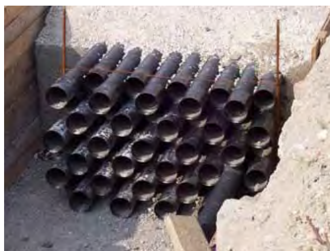
Přivaděč na most Apolo Bratislava Privádzač na most Apolo Bratislava
