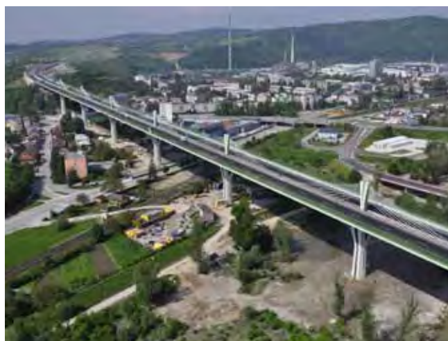
Estakáda Považská Bystrica Estakáda Považská Bystrica
